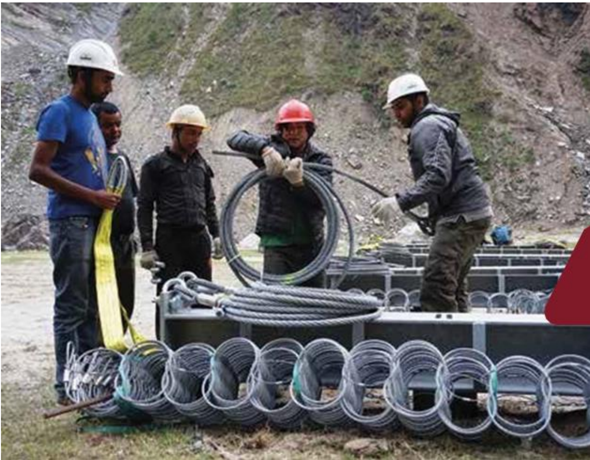
Рис. 5. Подготовка опор и пакетов сетей Омега к установке монтажной бригадой с помощью вертолета
