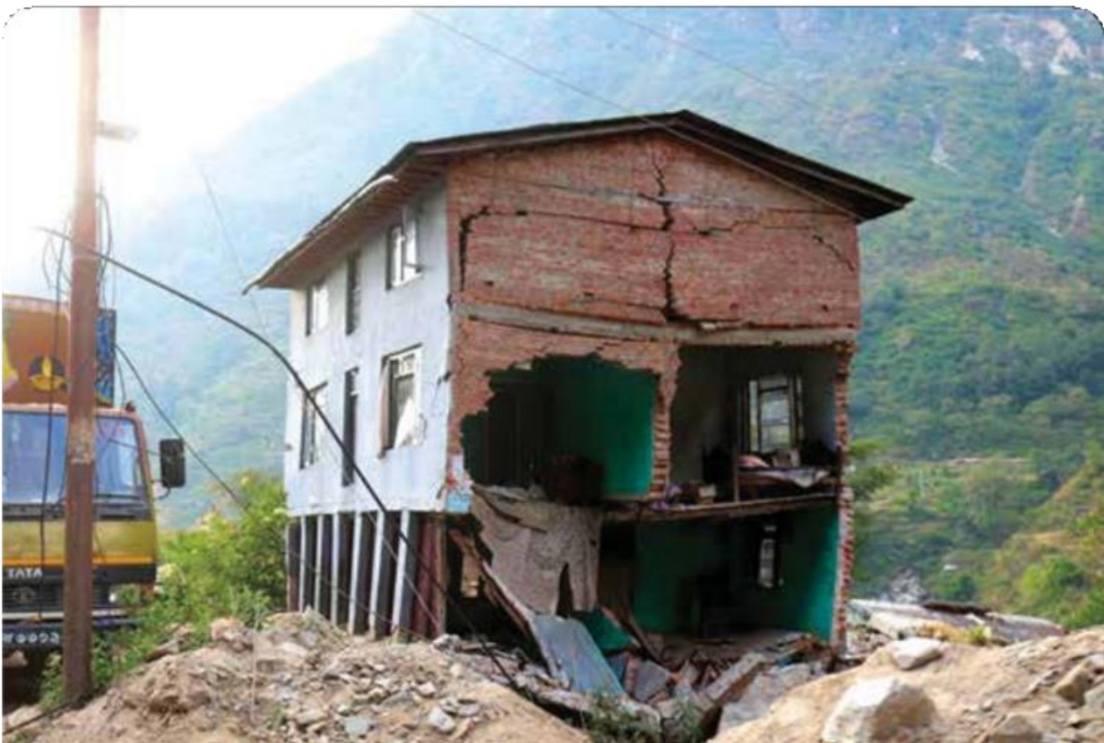
Рис. 1. Жилой дом, разрушенный землетрясением, недалеко от гидроэлектростанции Бхоте-Коши
