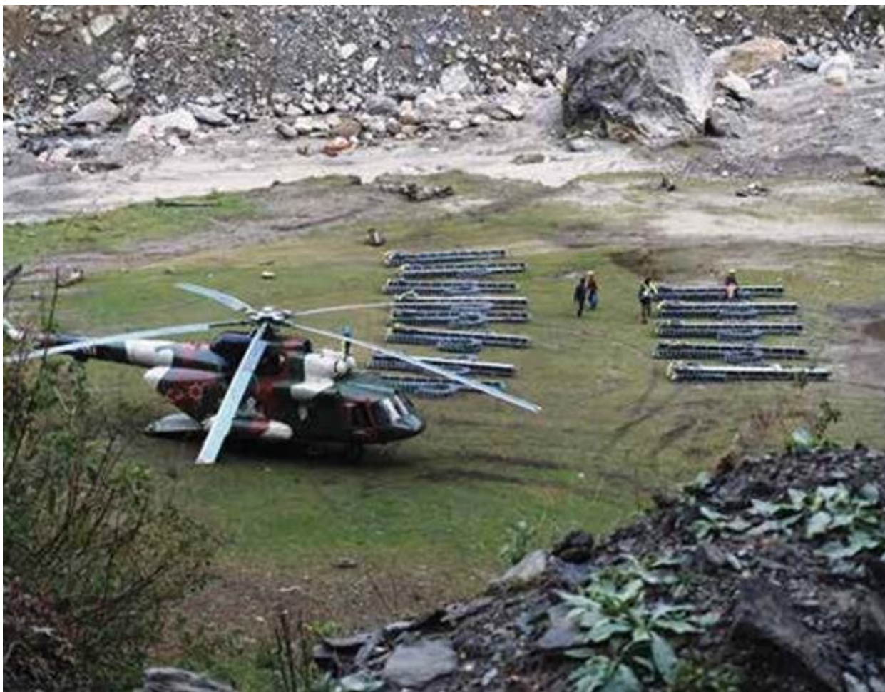
Рис. 3. Подготовка противокампнепадных систем к монтажу с помощью российского транспортного вертолета Ми-17, принадлежащего непальской армии
