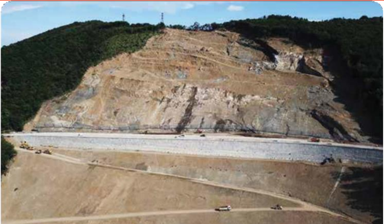
Рис. 6. Зона отрыва скальной породы с недавно построенной дорогой
