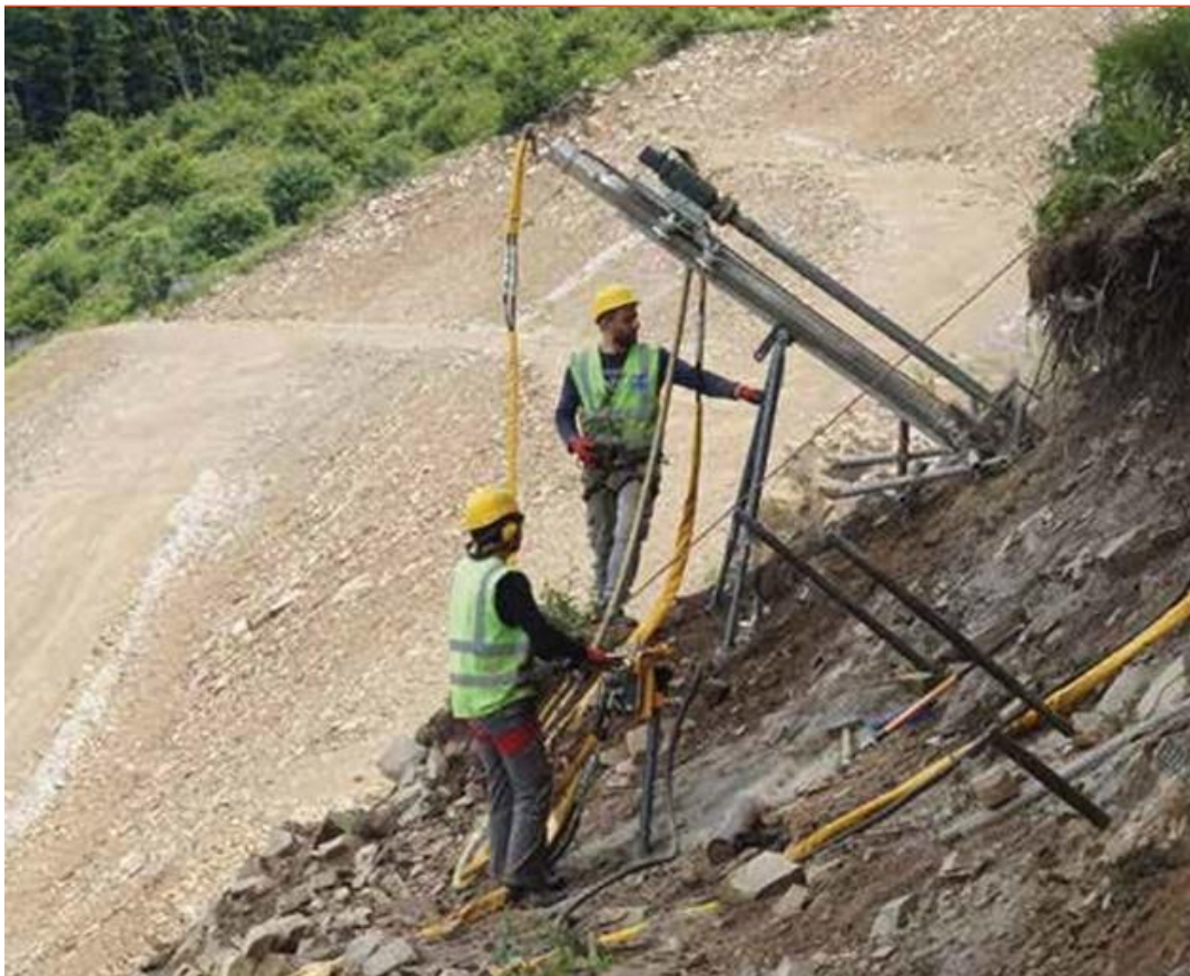
Рис. 7. Буровые работы для стабилизации края оползня
