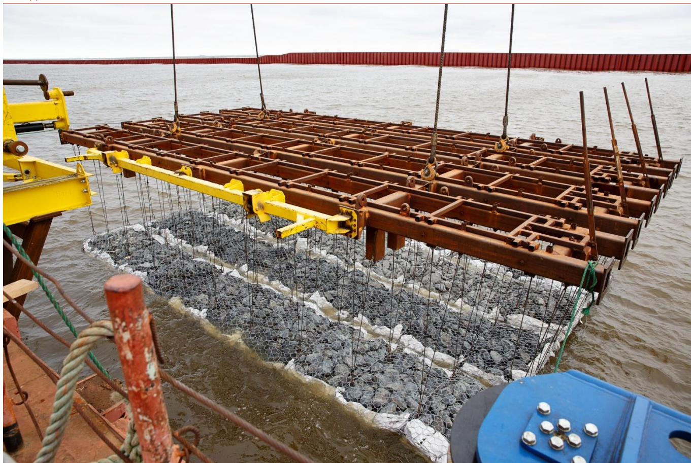
Рис. 7. Укрепление матрацами Рено подпричального пространства в порту «Сабетта»
