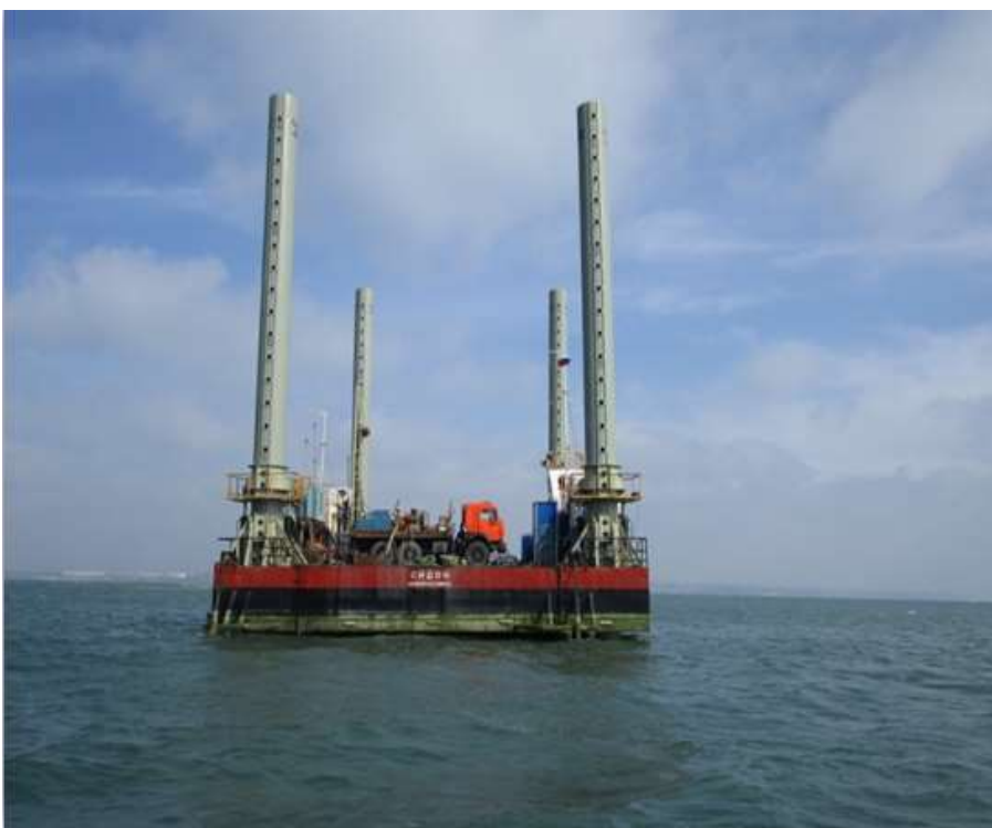
Рис. 1. Проходка буровых скважин на воде с понтона
