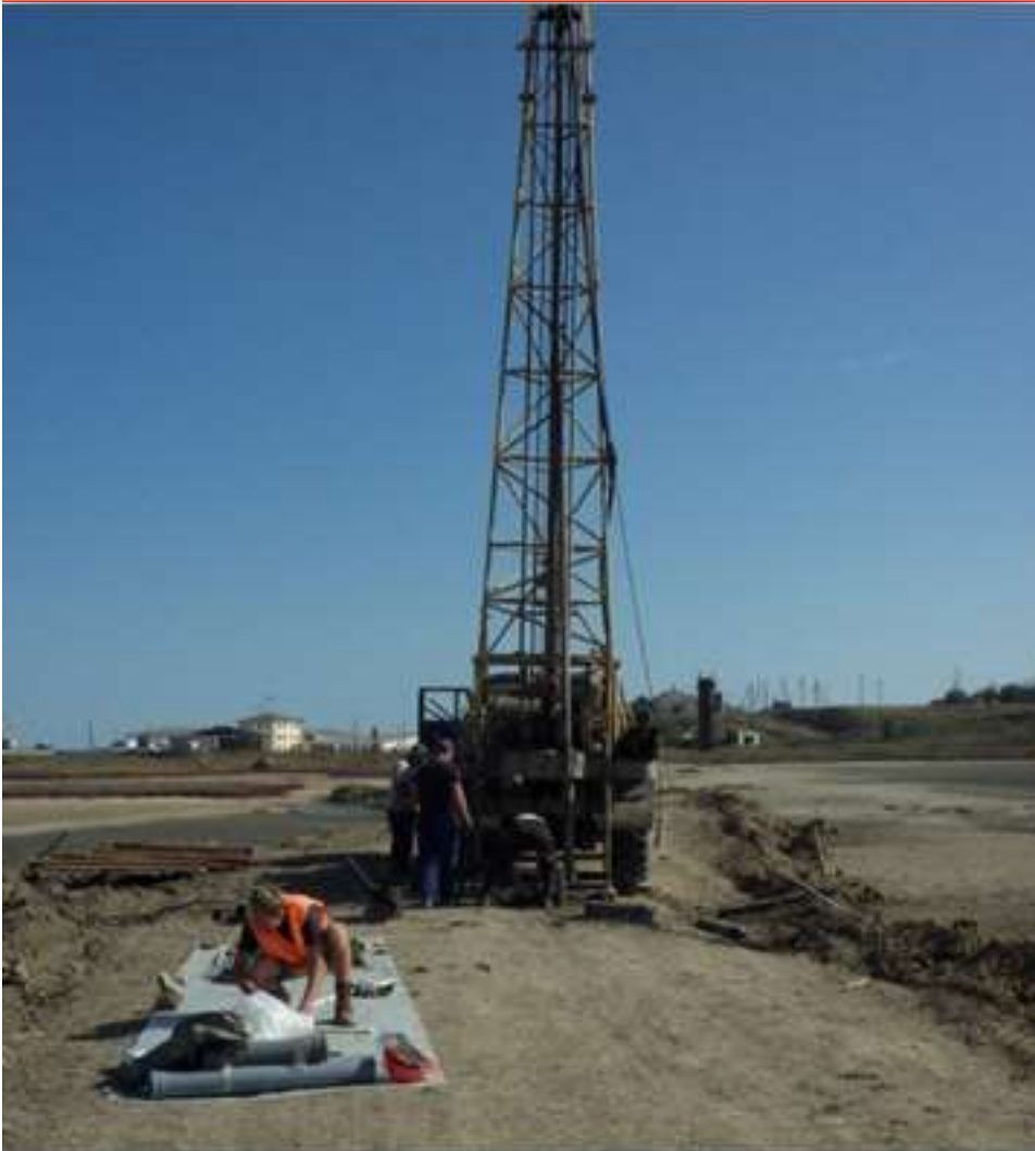
Рис. 2. Проходка буровых скважин на суше
