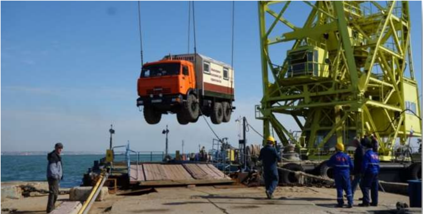
Рис. 3. Доставка установки при помощи плавкрана
