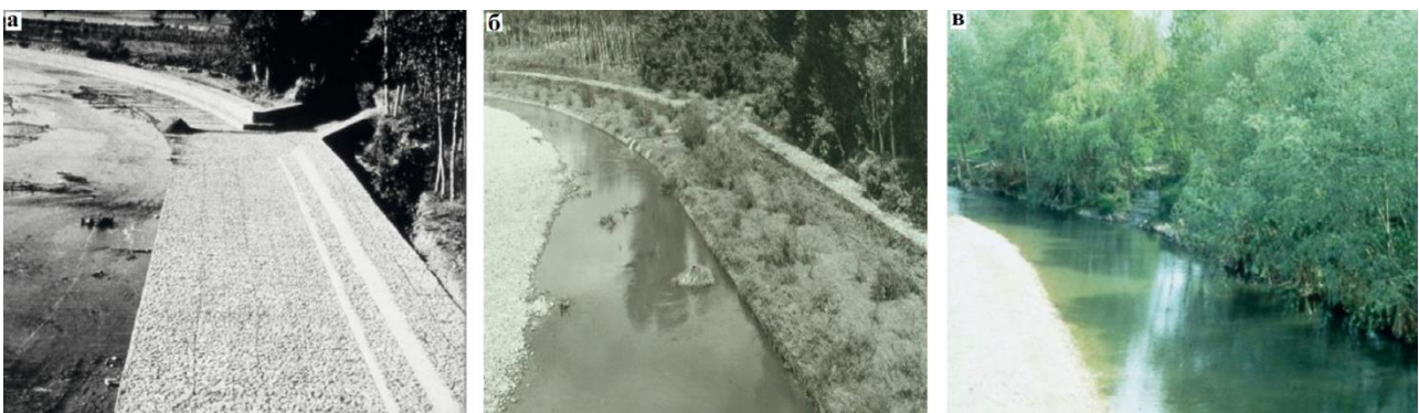
Рис. 8. Берегоукрепление с помощью комбинации матрацевидных и обычных габионных конструкций: а – строительство берегоукрепительной системы; б – начало образования растительного покрова на ней; в – выросший на ней лес
