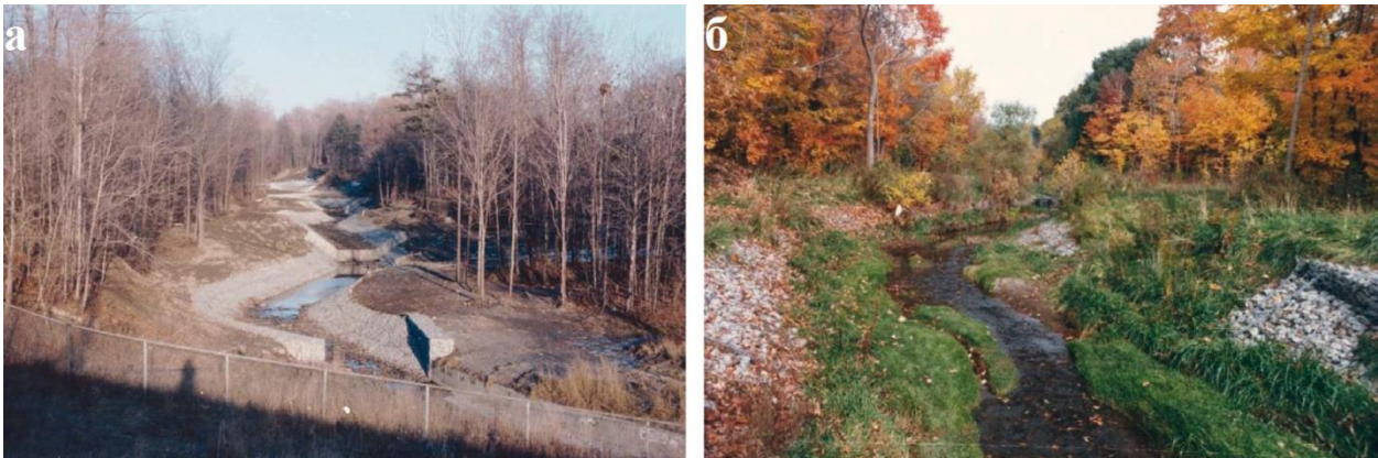
Рис. 9. Берегоукрепление с помощью комбинации матрацевидных и обычных габионных конструкций: а – строительство берегоукрепительной системы; б – образовавшийся на ней растительный покров
