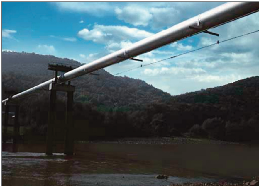
Рис. 9. Воздушный переход нефтепровода через реку
