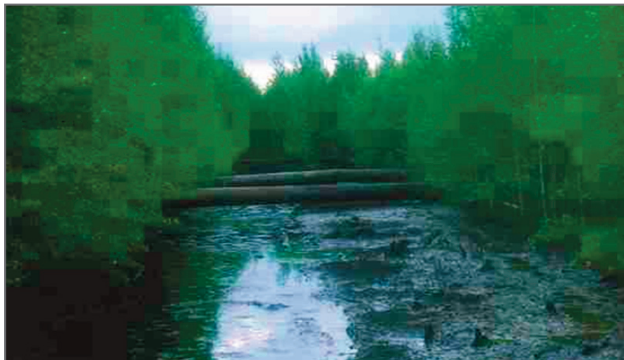
Рис. 12. Обнажение труб и пролив нефти на трубопроводе Сомотлорского месторождения (фото Е.А. Вознесенского, 1999 г.)
