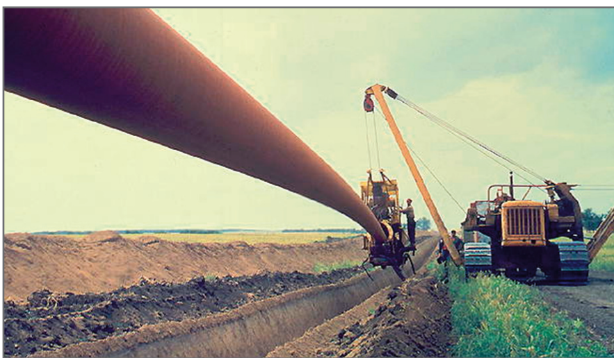
Рис. 8. Укладка магистрального газопровода в траншею
