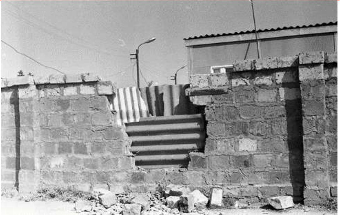
**Рис. 2.** Узкий, v-образный вывал в заборе на пересечении с аномалией СЗ направления
