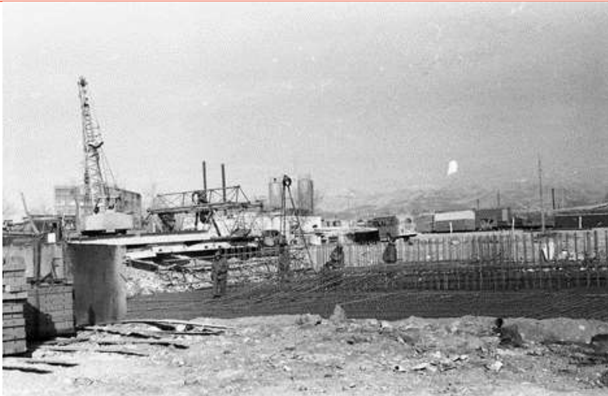
Рис. 4. Фундамент для 1-2-этажного «дома Рыжкова»
