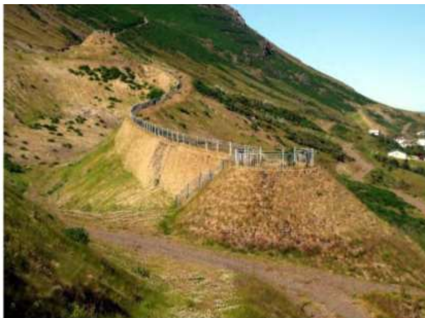
Рис. 4. Одна из противолавинных дамб над городом Сиглюфьордюр в Северной Исландии. Ее конец сформирован в виде бастиона с наклонными стенами. По верху идет пешеходная тропа с защитным ограждением с двух сторон [1]
