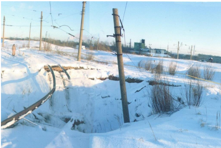
Рисунок 2 – Карстовый провал, Нижний Новгород (произошел в 2007 г. под разворотным кольцом железнодорожных путей, диаметр 18 м, глубина 4,5 м)
