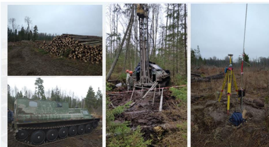
Рис. 4. Подготовка территории для строительства газоперерабатывающего комплекса вблизи поселка Усть-Луга
