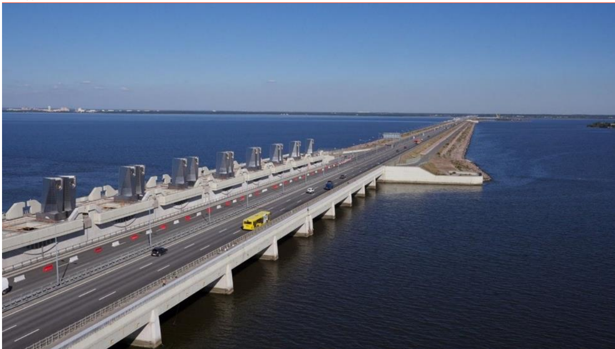
Рис. 4. Фрагмент защитной дамбы г. Санкт-Петербурга [12]
