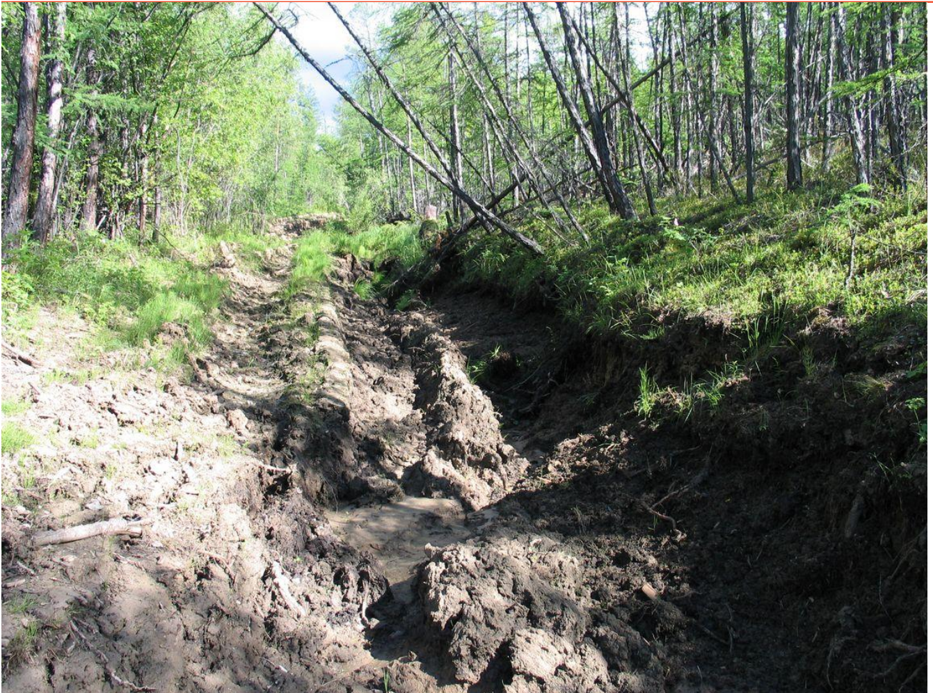
Рис. 4. Термоэрозионные последствия бессистемного движения гусеничной техники на участке трассы ж/д Томмот-Кердём. 2006 г. (фото Л.Г. Нерадовского).
