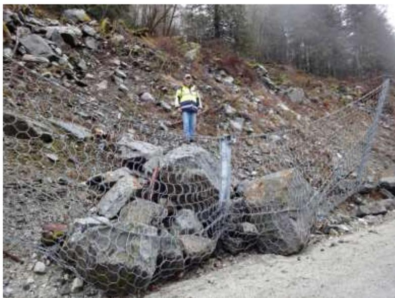
**Рис. 6.** Деформация стойки гибкого противокаменпадного барьера Trumer в Канаде после воздействия крупных скальных блоков в 2011 году [6, 7]
