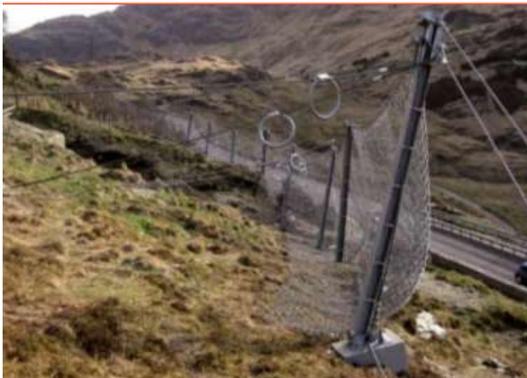
**Рис. 2.** Внешний вид варианта гибкого противокаменного барьера [2]
