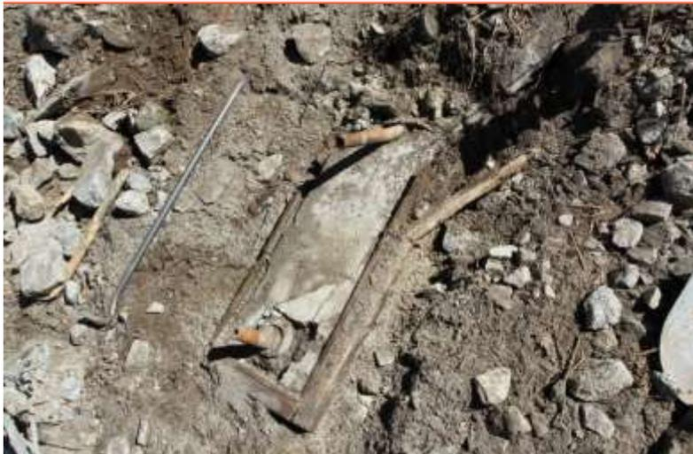
**Рис. 7.** Состояние фундамента деформированной стойки гибкого противокамнепадного барьера Trumer в Канаде после воздействия крупных скальных блоков в 2011 году [6, 7]
