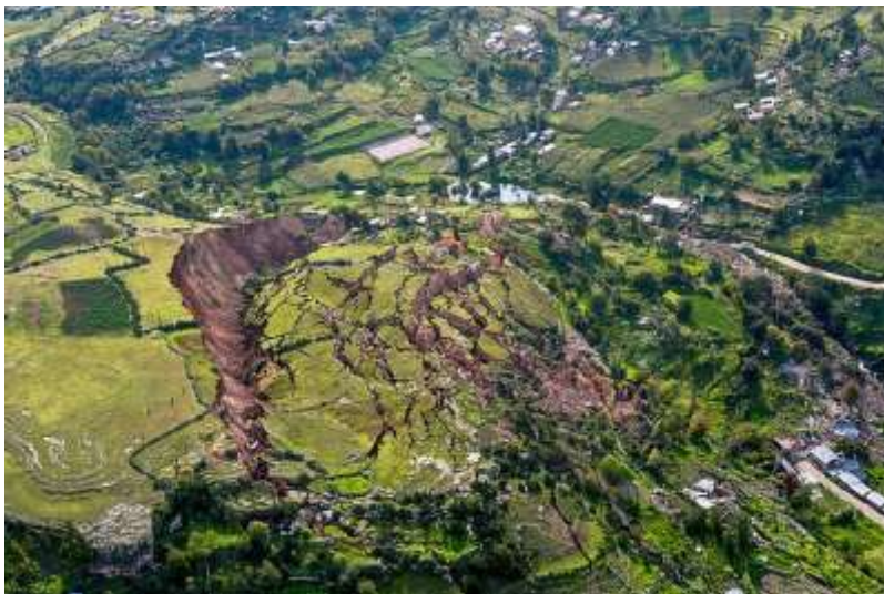
Рис. 5. Гигантский оползень с трещинами, разрушивший часть города Лутто Кутуто в перуанском регионе Куско в марте 2018 года [28]
