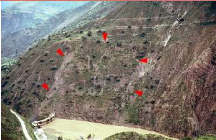
Рис. 4. Смещение активизировавшейся части древнего оползня (указанное красными стрелками), ставившее под угрозу плотину и электростанцию Таблачака на реке Рио-Мантаро в Перу до принятия дорогостоящих контрольных мер [29, 32]
