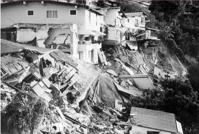
Рис. 2. Дома в дорогом жилом районе Каракаса в Венесуэле, которые были разрушены в сентябре 1993 года в результате вызванного сильными дождями оползня [19, 27]
