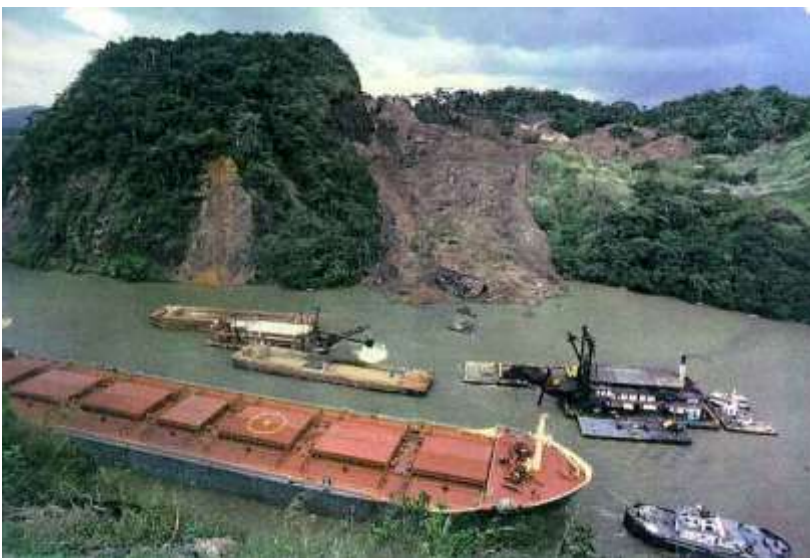
Рис. 16. Повторная активизация оползня Кукарача на Гайлардском (Гайярском) участке Панамского канала в октябре 1986 года. На этот раз его объем составил 4,6 млн куб. м и он прошел почти поперек всего канала, но к моменту выполнения
