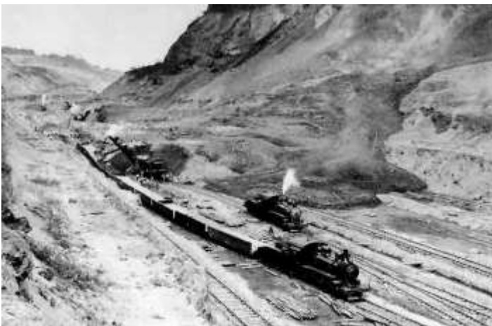
Рис.15. Оползень Кукарача объемом 2,2 млн куб. м сошедший в 1913 году на Гайлардском (Гайярском) участке Панамского канала, когда на его будущем дне еще строились железнодорожные пути для грузовых поездов. Активность этого оползня продолжалась во время и после заполнения канала водой (рис. 14) [35, 38]
