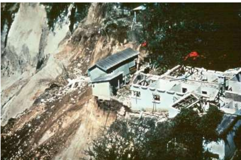
Рис. 4. Повреждения, вызванные одним из оползней, спровоцированных землетрясением в Гватемале в феврале 1976 года [31, 38]
