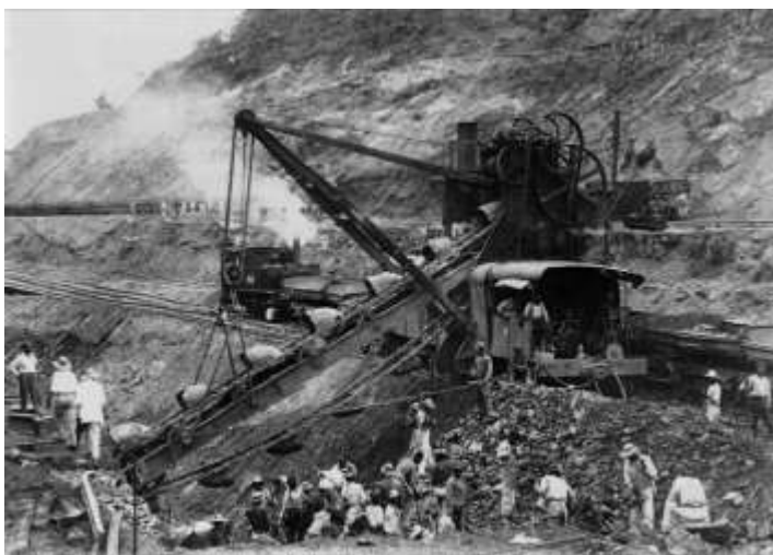
Рис. 14. Строительство Панамского канала [12]
