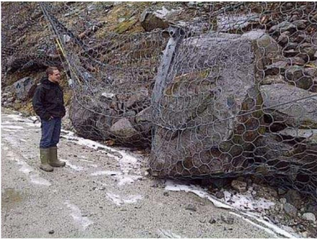
Рис. 8. Камнеулавливающий барьер после камнепада в декабре 2011 года [1]
