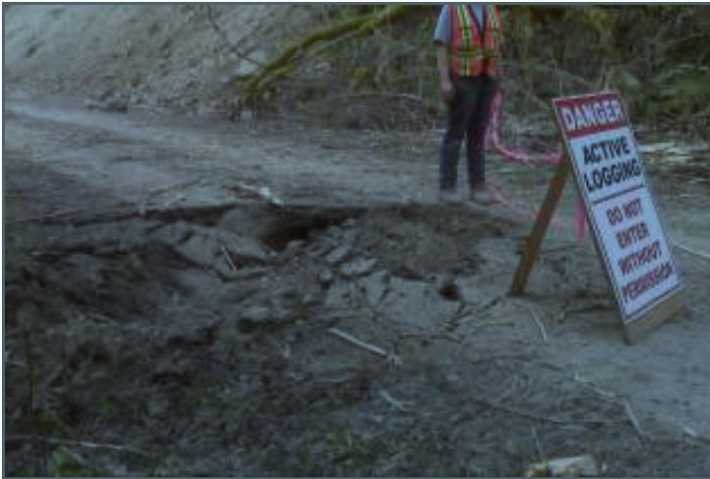
Рис. 2. Место удара валуна о подъездную дорогу [1]
