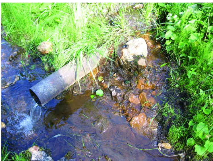
Рис. 1. Осадок гидроксида трехвалентного железа в дренажной канаве
