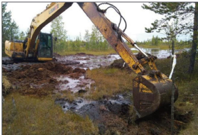
Рис. 3. Срезка слоев торфа с высоковязкой забитумизированной нефтью с помощью экскаватора (фото В.С. Королева)
