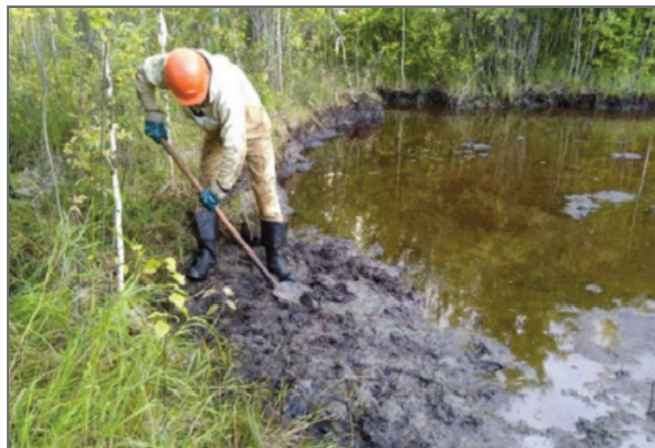
Рис. 4. «Доработка» срезки нефтезагрязненного торфа ручным способом (фото В.С. Королева)
