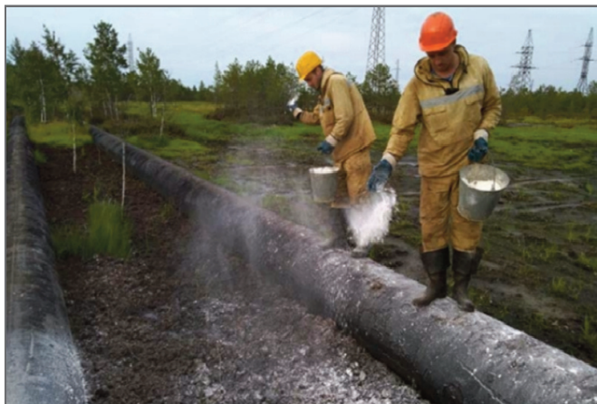
Рис. 19. Внесение доломитовой муки на поверхность торфа (фото В.С. Королева)
