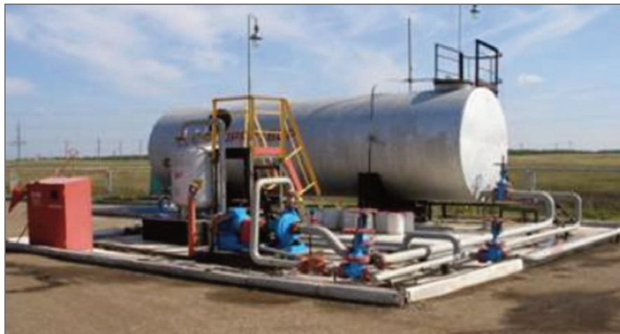
Рис. 16. Блок для приготовления рабочих растворов биопрепаратов (источник фото: www.newchemistry.ru )
