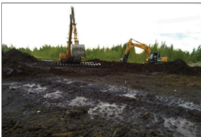
Рис. 17. Проведение работ по мульчированию торфом с использованием экскаваторов (фото В.С. Королева)
