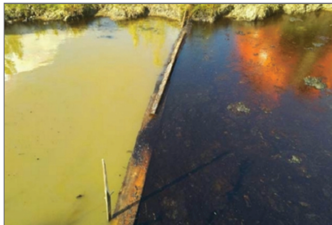
Рис. 6. Разница между частью водоема, где была произведена откачка жидкой нефти (слева) и местом, где еще не была выполнена очистка (справа) (фото В.С. Королева)
