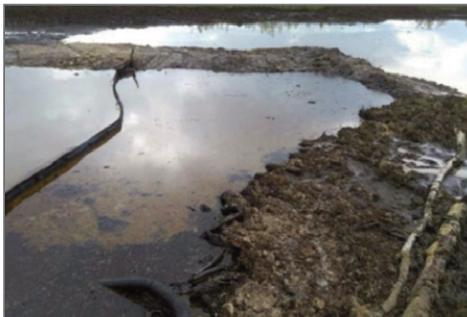
Рис. 5. Откачка жидкой нефти с водной поверхности. Видно боновое заграждение (фото В.С. Королева)
