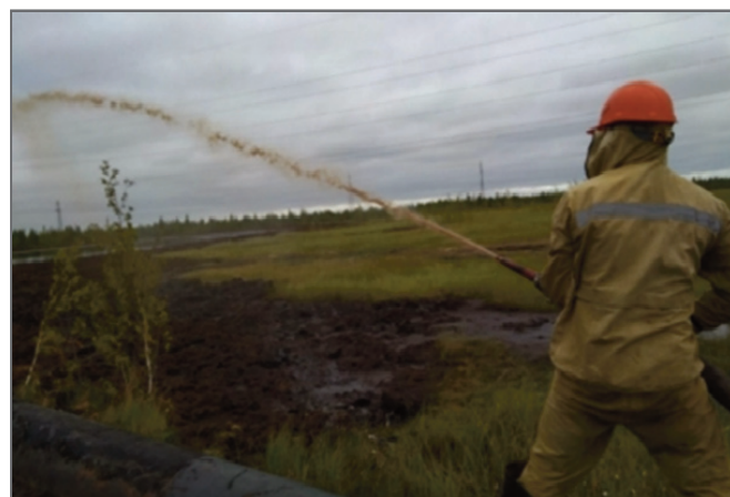
Рис. 18. Внесение на поверхность торфа гумата натрия (фото В.С. Королева)
