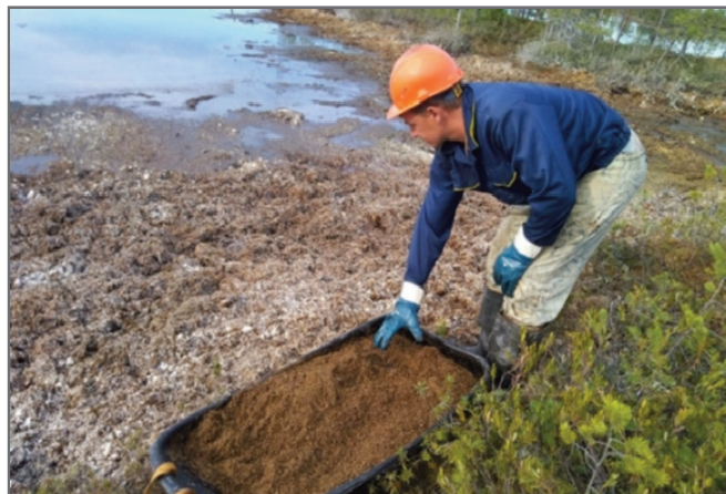
Рис. 20. Работы по фитомелиорации – посев семян ручным способом (фото В.С. Королева)
