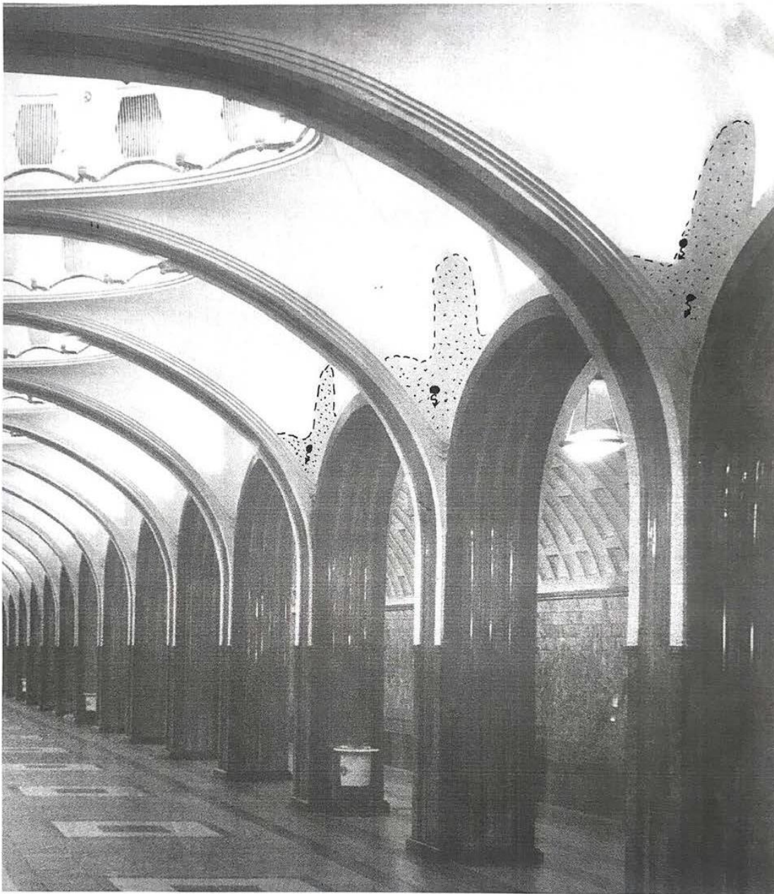
Рис. 2. Места просачивания воды в парусах колонн
