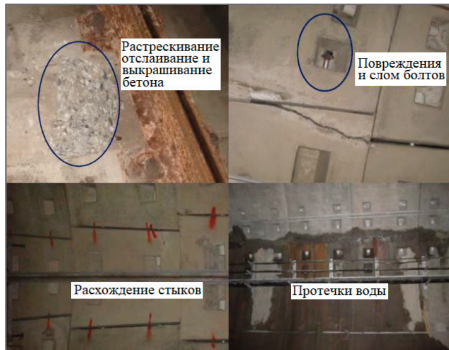
Рис. 1. Угрозы безопасности тоннеля метро в Шанхае, вызванные случайной избыточной нагрузкой на поверхность от наземного транспорта
