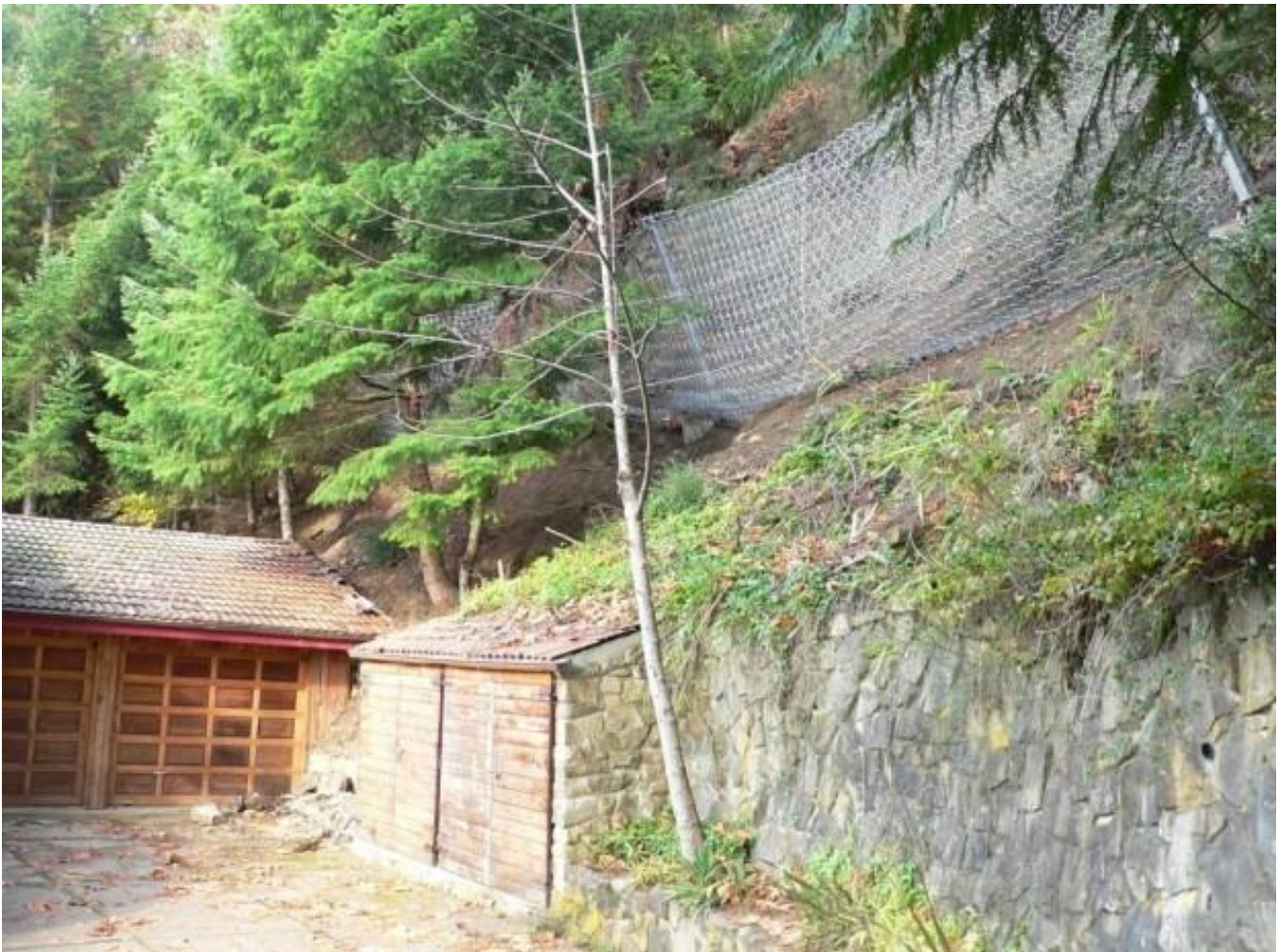
Рис. 8. Противокампнепадный барьер, рассчитанный на энергию удара до 500 кДж, защищающий гараж рядом с частным домом на острове Мейн [8]
