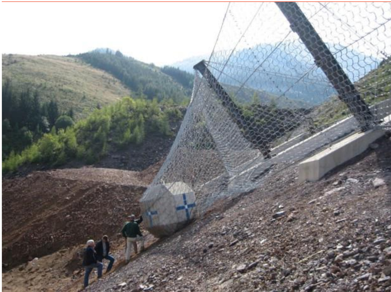
Рис. 1. Испытание камнеулавливающего барьера на удар бетонного снаряда массой 13 т, движущегося со скоростью 100 км/ч (то есть на энергию удара 5000 кДж) [8]
