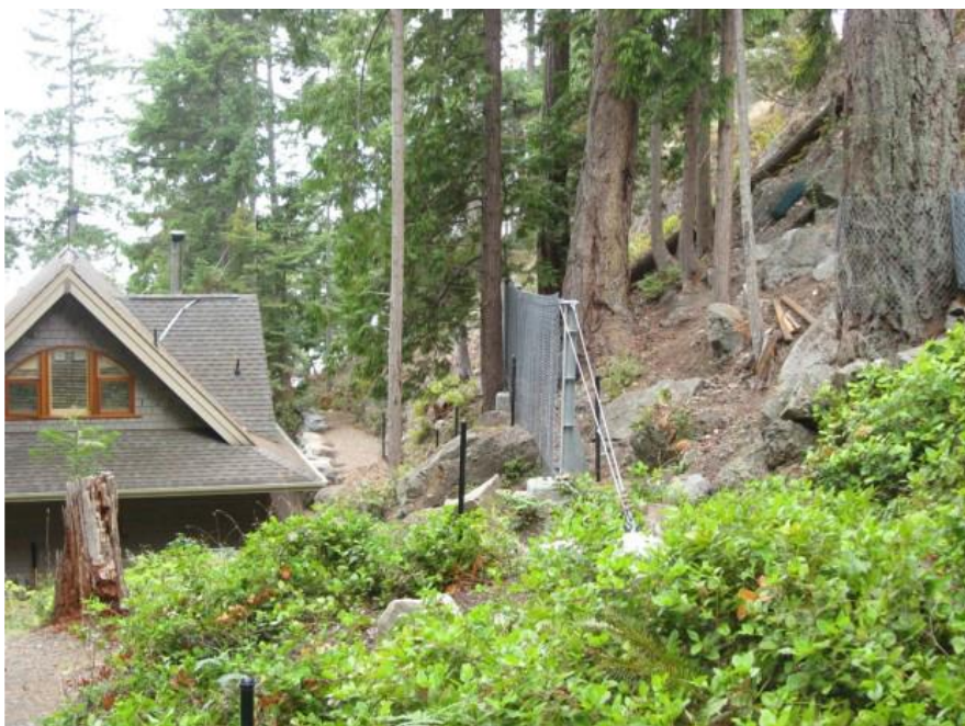
Рис. 6. Камнеулавливающий барьер над жилым домом на острове Пендер [8]
