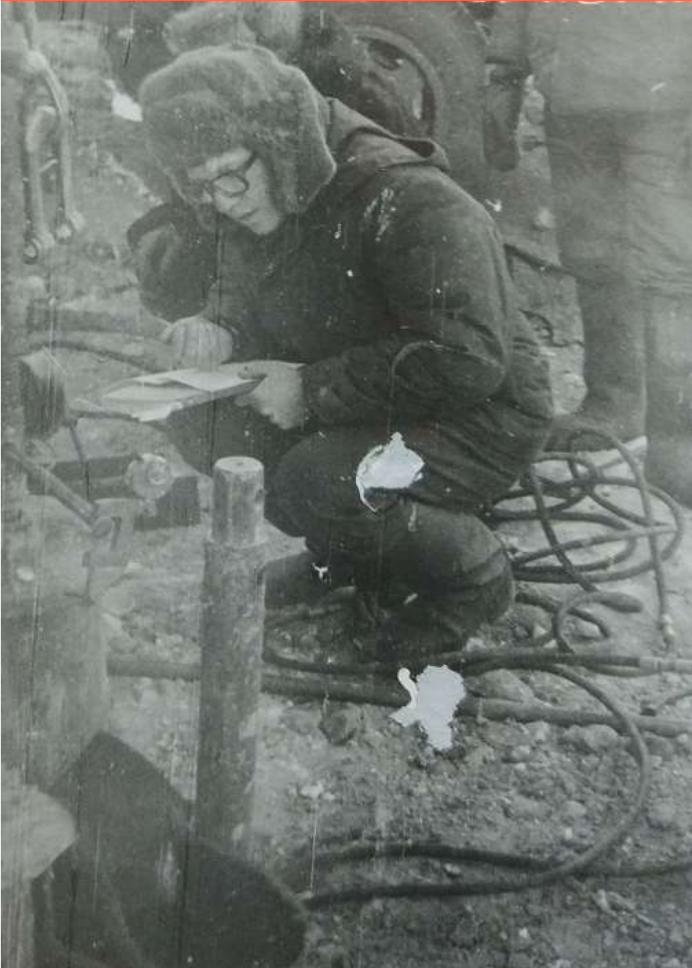
Рис. 4. Автор настоящей статьи регистрирует полученные значения в ходе первых испытаний грунтов лопастным прессиометром ЛПГ-42
