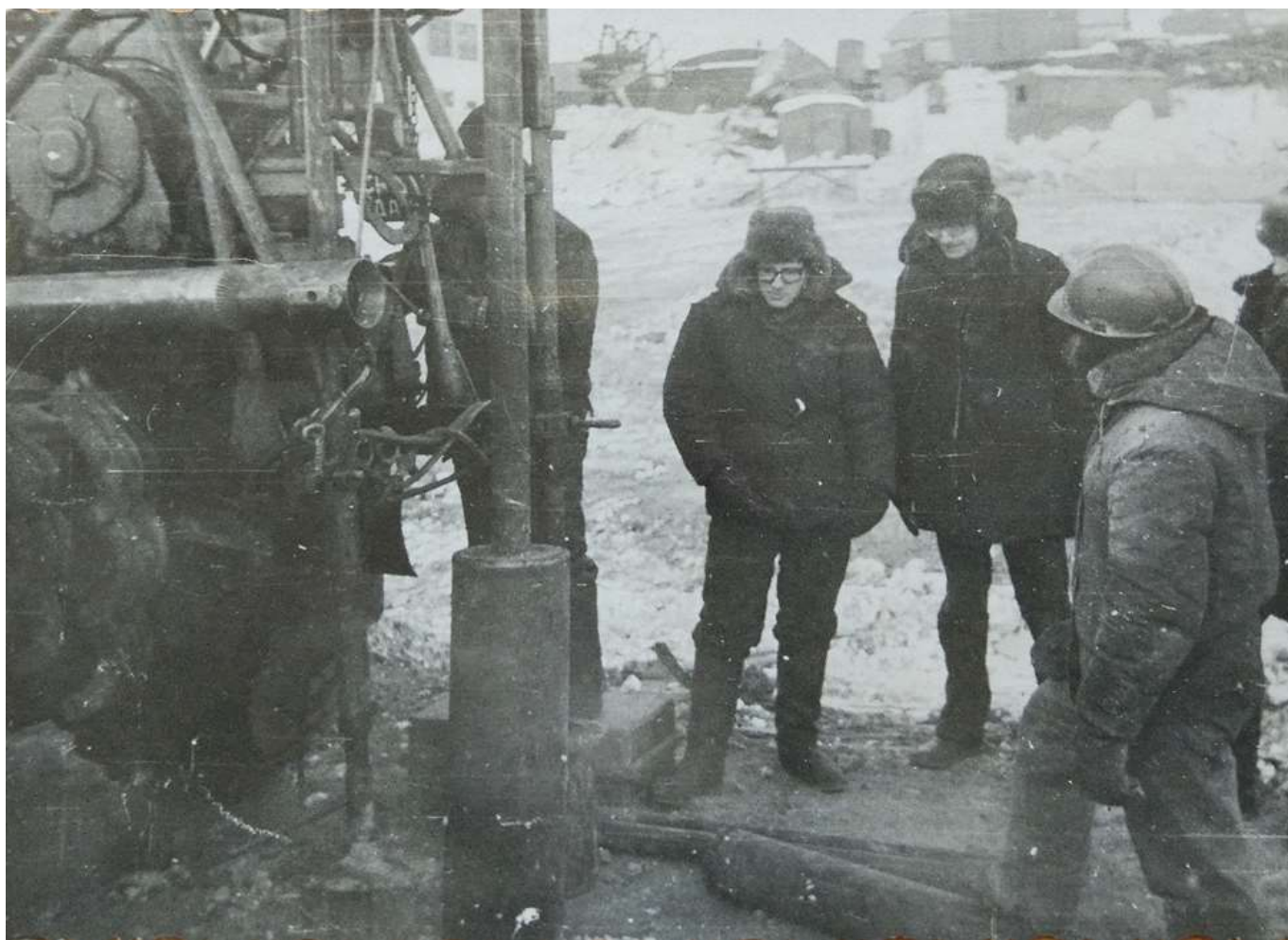
Рис.2. Проходка первой технической скважины для испытаний лопастным прессиометром в условиях Северо-Востока СССР. В центре – автор статьи.
