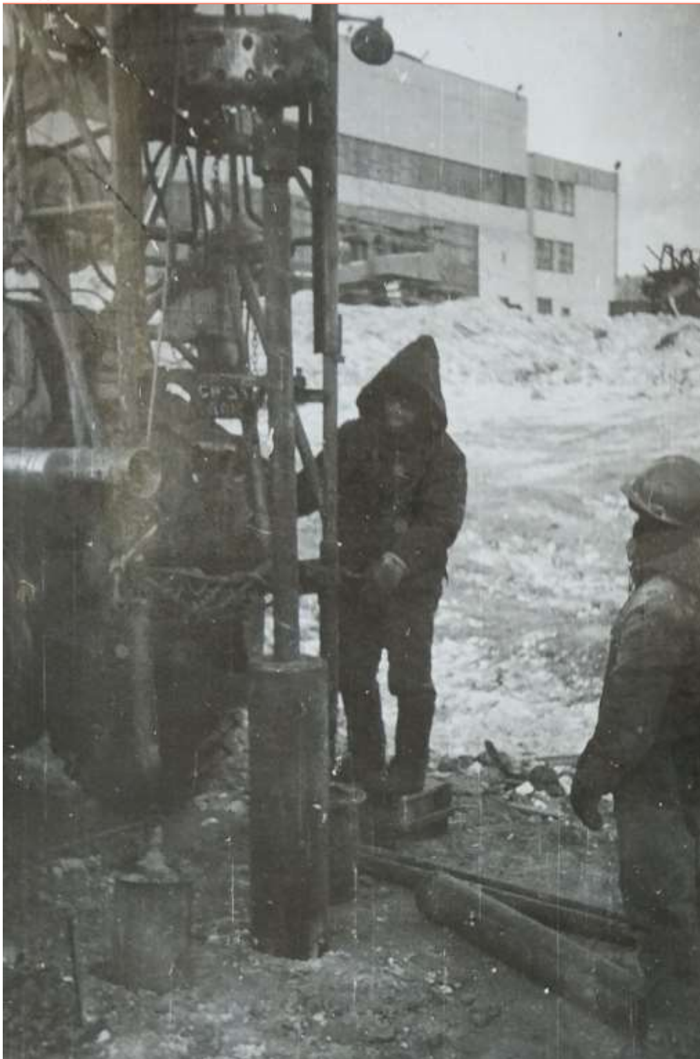
Рис.3. Бурение технической скважины коротким колонковым буровым снарядом с зубьями Бара (система пневмовыдува керна пока отсутствует)
