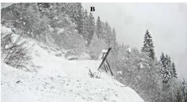
**Рис. 4.** Последовательные кадры схода снежно-пылевой лавины 13 января 2019 года: а – приближение лавины; б – взаимодействие лавины с барьером; в – лавинные отложения, задержанные барьером [4]
