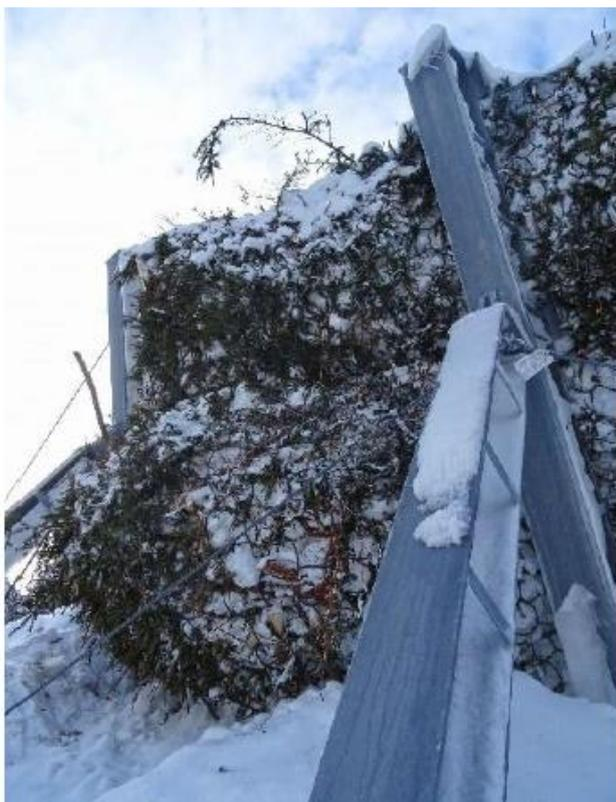
**Рис. 6.** Ветки со снегом, задержанные сеткой барьера при сходе лавины 14.01.2019 [4]
