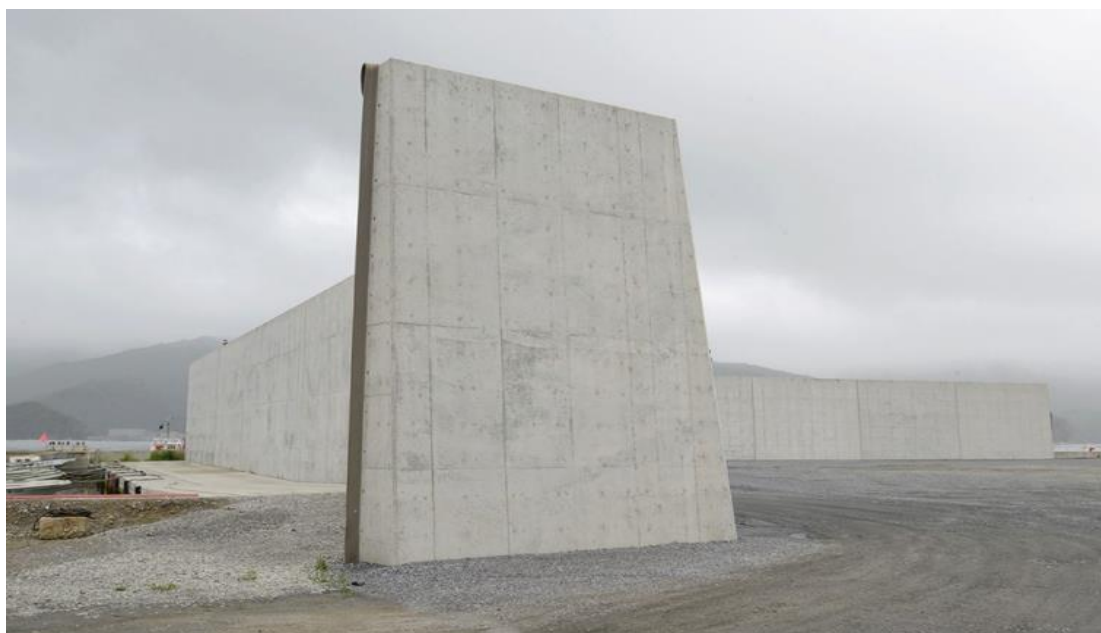
Рис. 4. Общий вид цунамизащитной стенки (высота 12 м)
