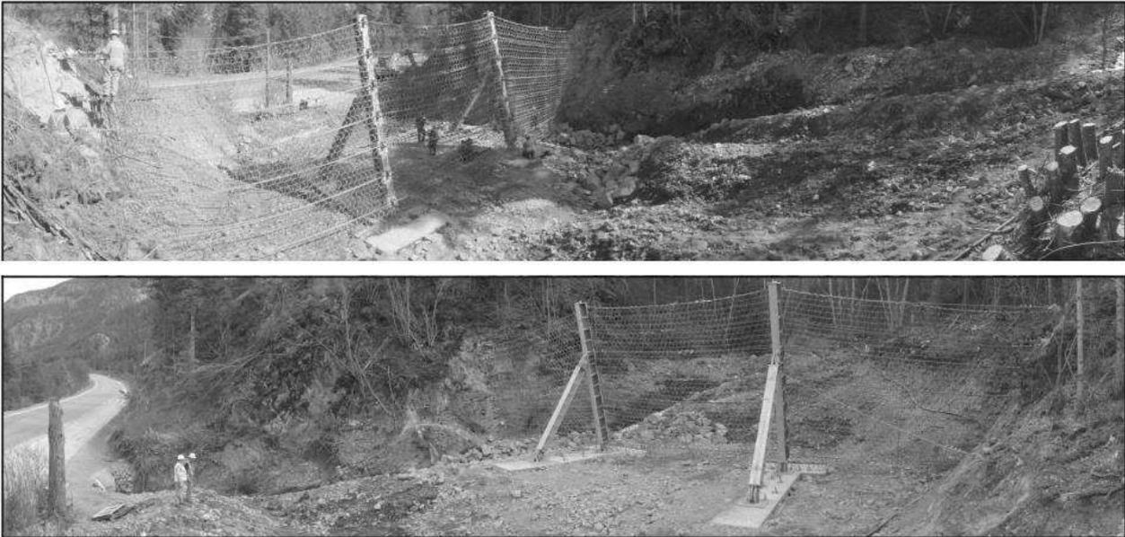
**Рис. 9.** Смонтированный гибкий противоселевой барьер Debris Catcher [1]
