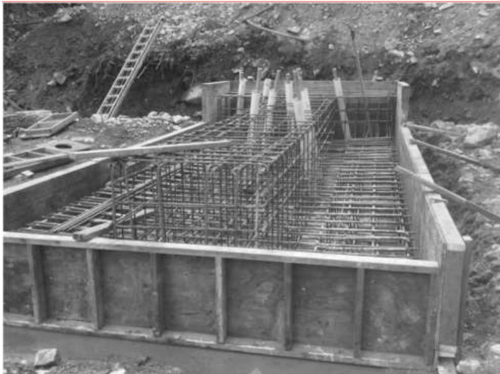
**Рис. 8.** Стальной каркас фундамента опорной конструкции и тросовые анкеры в муфтах из ПВХ до заливки бетонного раствора [1]
