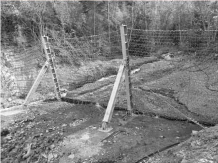
**Рис. 10.** Накопление некоторого количества обломочного материала в основании противоселевой системы Debris Catcher [1]
