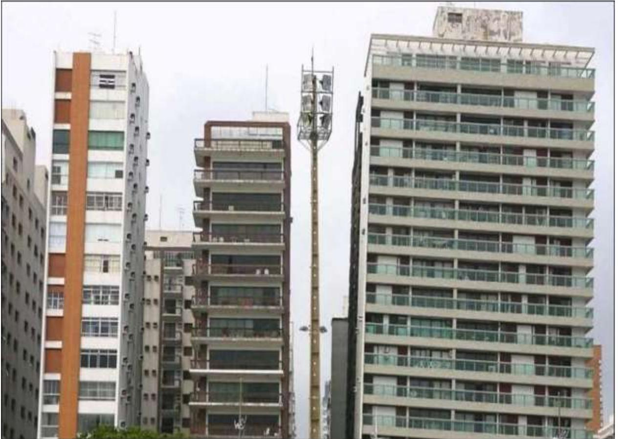
**Рис. 2.** Опасный крен дома в результате динамического воздействия от движения трамваев в условиях плотной городской застройки (из презентации Олега Озмидова на курсах повышения квалификации)
