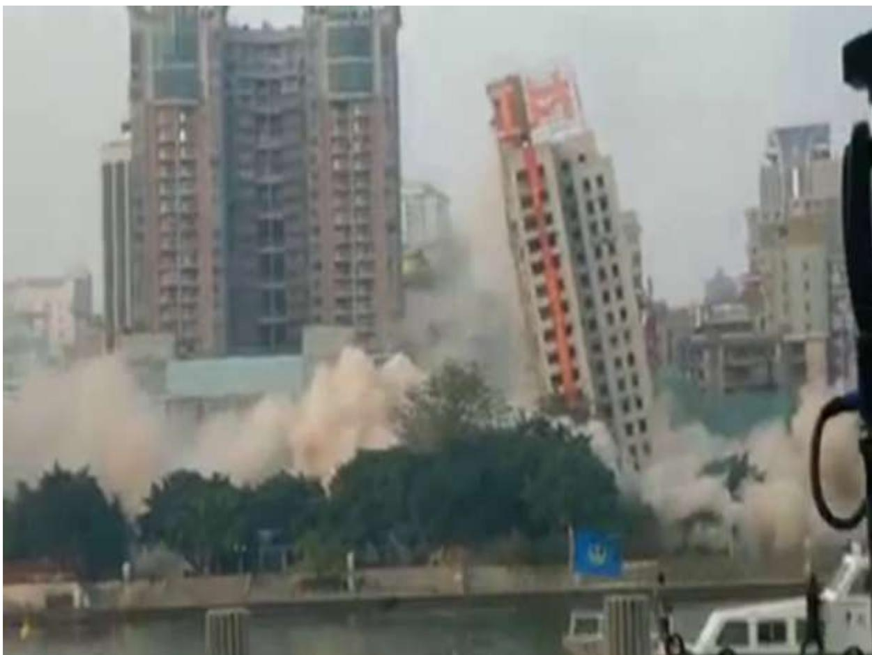
**Рис. 3.** Падение не разрушившегося здания из-за явления виброразжижения (из презентации Олега Озмидова на курсах повышения квалификации)
