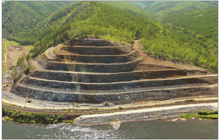
Рис. 7. Проведение строительно-монтажных работ на склоне
