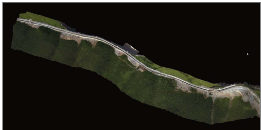
Рис. 9. Ортофотоплан участка с построенными защитными сооружениями
