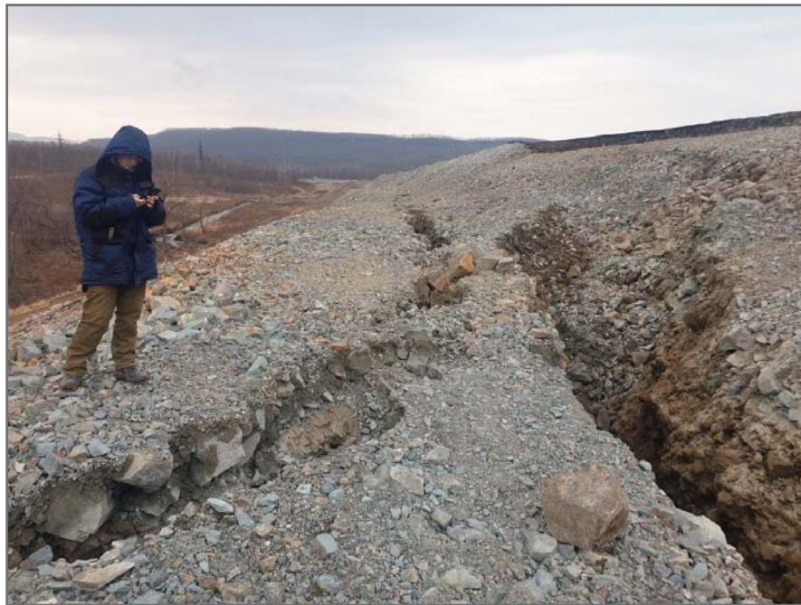
Рис. 4. Работы по обследованию оползня
