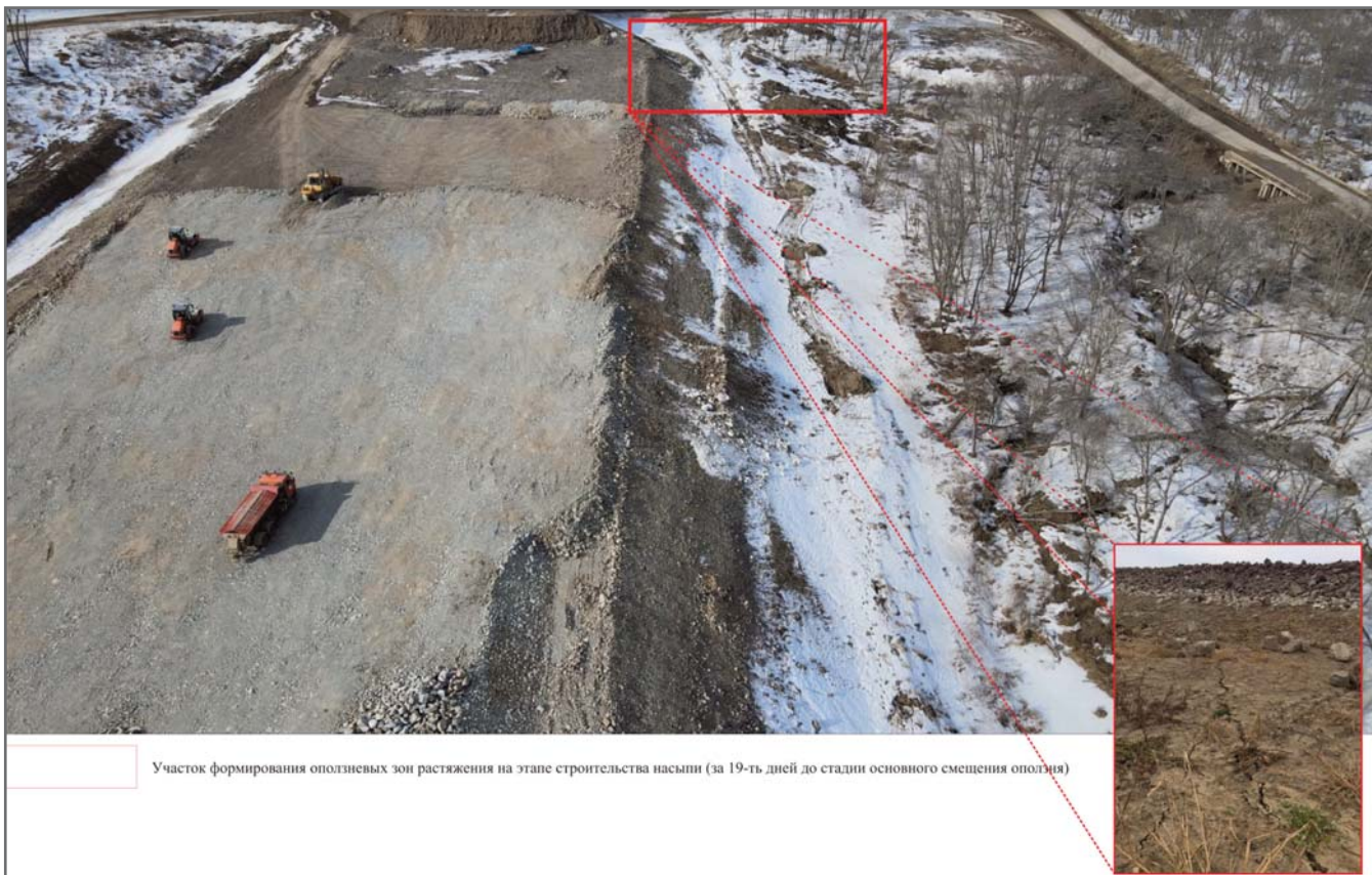
Рис. 1. Участок формирования оползневых зон растяжения на этапе строительства насыпи (за 19 дней до стадии основного смещения оползня)
