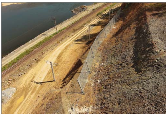
Рис. 5. Установленный противокампнепадный барьер TSC-500-ZD высотой 4 м
