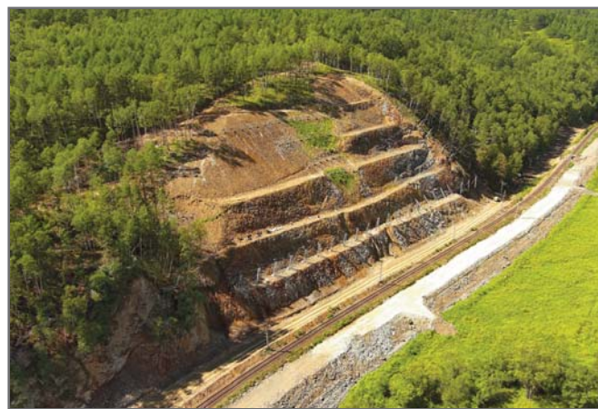
Рис. 6. Процесс монтажа снегоудерживающих барьеров Snow Rake Dk 2.0
