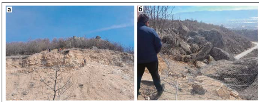
Рис. 4. Применение противокамнепадных мер над участком дороги, ведущей из города Струмица в город Берово, с использованием специальных комбинаций проволочной сетки с анкерными болтами (нагельями) и стальными тросами
